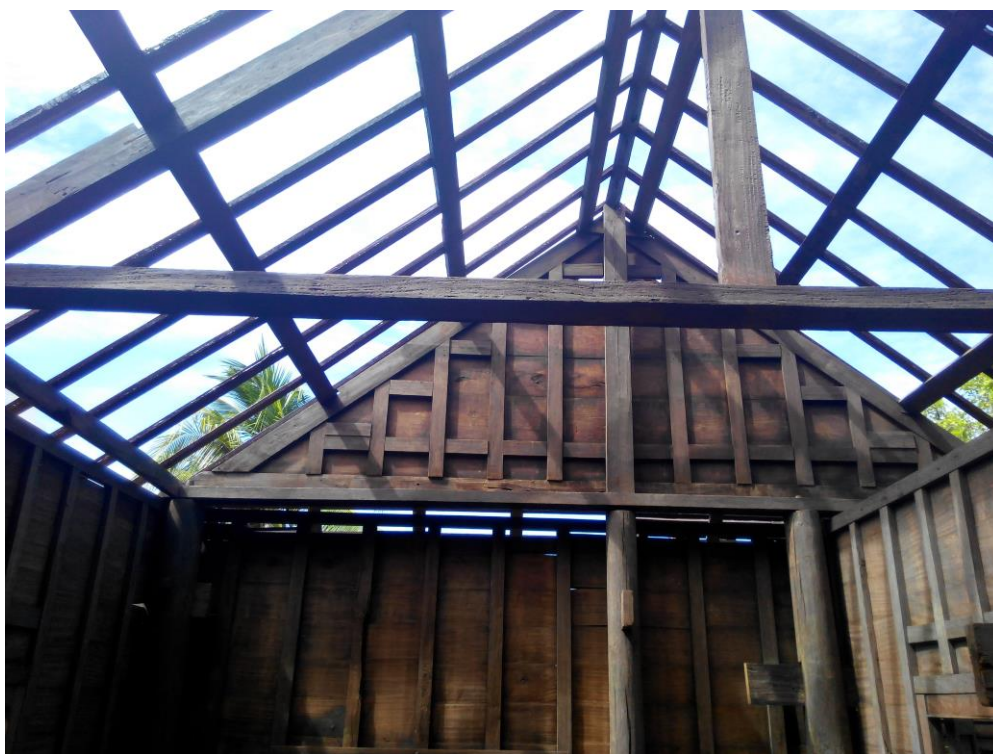
ภาพที่ 20 โครงหลังคาของเรือนนอน ประกอบไปด้วย ชี้อ ตั่ง ออกไก่ แป้วเส้า แป่ลาน กลอน และหน้าจั่ว
