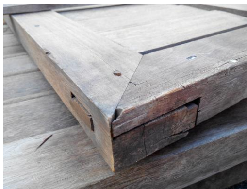
ภาพที่ 10 การเข้าเดือยแบบปากกบบริเวณมุมกรอบฝา
