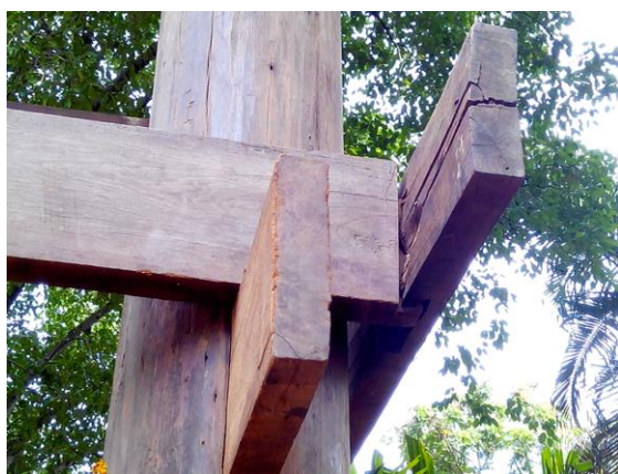
ภาพที่ 18 การเข้าไม้บริเวณที่พรี้งด้านยาวและด้านสกัดมาบรรจบกัน
