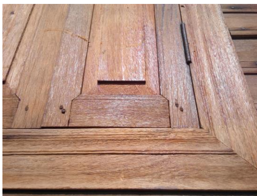
ภาพที่ 11 การเข้าไม้ของหน้าต่างโดยวิธีสอดสลักเข้าเดือย
