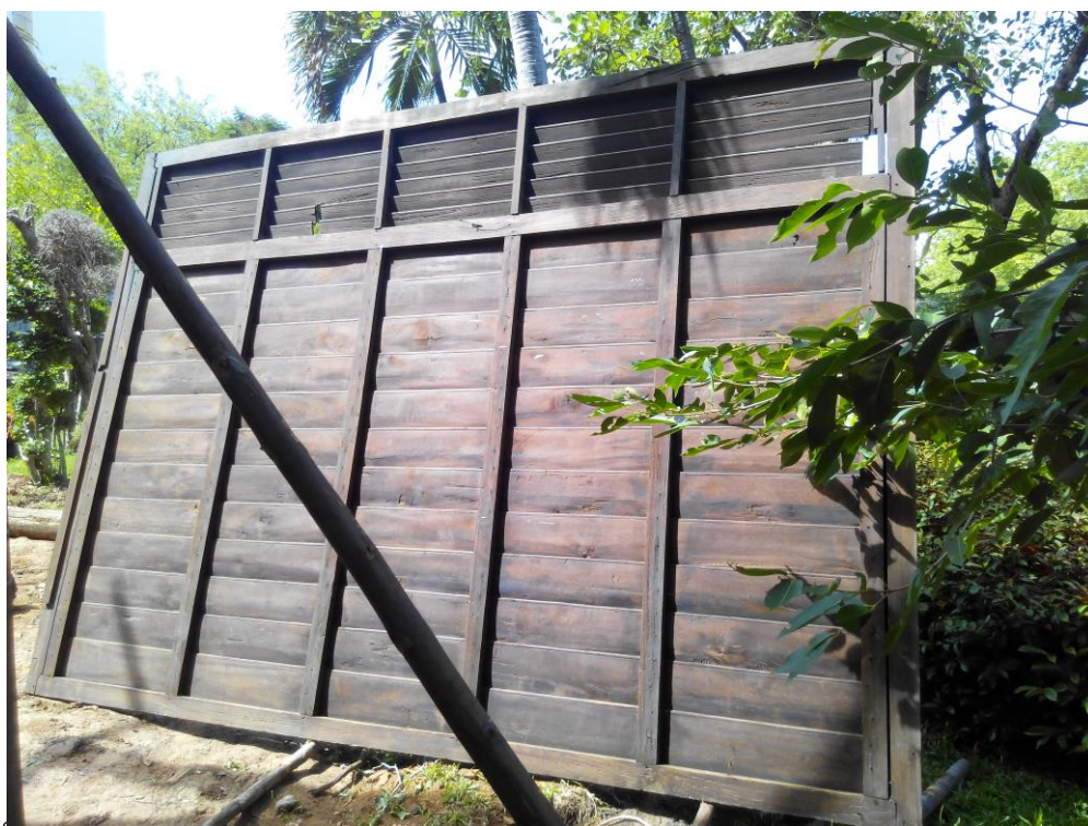
ภาพที่ 12 ฝาและกระดานที่แฉกและรื้อลงแล้วของสมเด็จเจ้าพระยาฯ ที่วัดสุทัศน์ฯ กรุงเทพมหานคร ภายหลังจากที่วัดได้บูรณะและยกยื้อแผ่นกระดานกับโครงตั้งด้วยตะปู แต่องค์ประกอบส่วนอื่นยังมีการเข้าไม้รูปแบบเดิม
