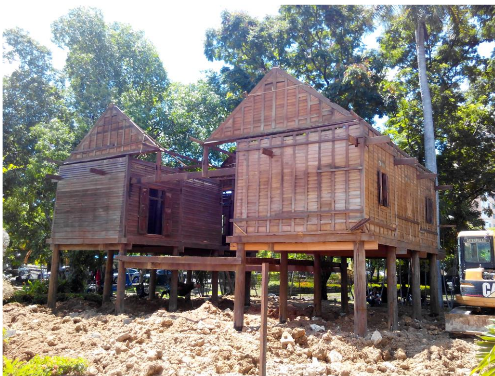
ภาพที่ 7 ลักษณะการปรุงฝาเรือนที่สะท้อนถึงสมัยนิยม ฝาฝั่งซ้ายจากภาพเป็นฝาไม้กระดานตีแนวนอนมีเกล็ดช่องลม ส่วนฝาฝั่งขวาจากภาพเป็นฝาเข้าลิ้นไม้ซ้อนเกล็ดแนวนอน
