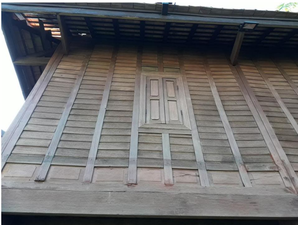
ภาพที่ 8 ฝาเข้าลิ้นไม้ซ้อนเกล็ดแนวนอนเป็นฝารูปแบบแบบดั้งเดิมที่นำมาปรุงเป็นแผงฝาด้วยวิธีการเข้าไม้ประกอบไปด้วยลูกฟัก ลูกตั้ง ลูกนอน ไม้กรุฝา และกรอบฝา
