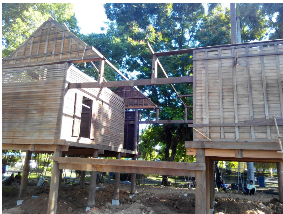
ภาพที่ 6 ลักษณะการบูรณการรูปแบบเรือนแฝดขึ้นใหม่ โดยการเปลี่ยนแปลงโครงสร้างทั้งระบบ ได้แก่ การเลื่อนตำแหน่งเสาดั้ง การยื่นช่อออกมาจากแนวเสาแล้ววางทับบนตึกตาซึ่งนั่งอยู่บนช่อค้ำ เพื่อรับหน้าจั่วขนาดใหญ่
