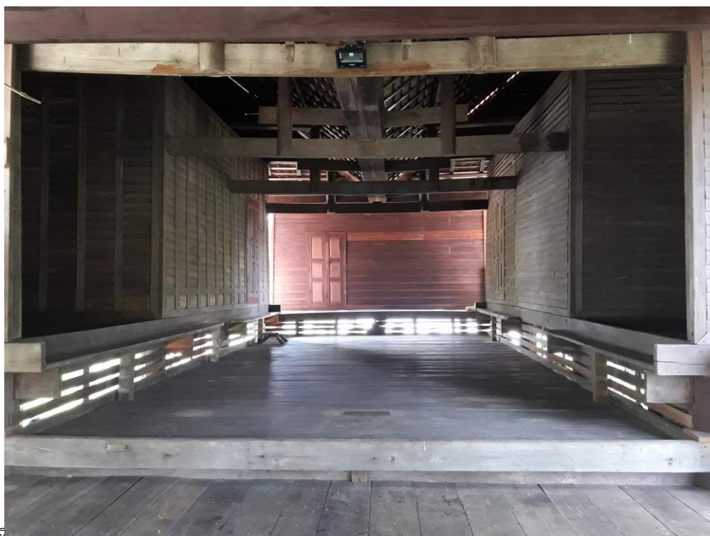
ภาพที่ ๖ สถาปัตยกรรมเรือนแพของชาวกะเหรี่ยงมอญจากบ้านตาดใหม่ จะเห็นแสงลอดจากหน้าต่างไม้กระดานและช่องว่างระหว่างซี่ไม้กระดานและซี่ไม้ค้ำยันและขาเป็นเรือนนอนขนาดสองช่วงเสา ส่วนช่วงเสาแรกเป็นโถงพักผ่อน ถัดไปด้านหลังเป็นครัว
