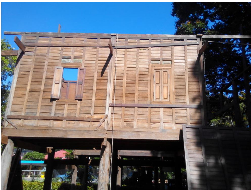
ภาพที่ 19 การนำไม้มาปรงเป็นแผงฝาแล้วยกประกอบกับตัวเรือนโดยวางบนพืดแล้วยึดด้วยเด้า
