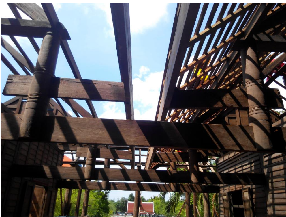
ภาพที่ 22 โครงหลังคาบริเวณโถงกลาง ประกอบไปด้วยซื่อคัด ตึกตา เค้า และไม้เชิงชาย
