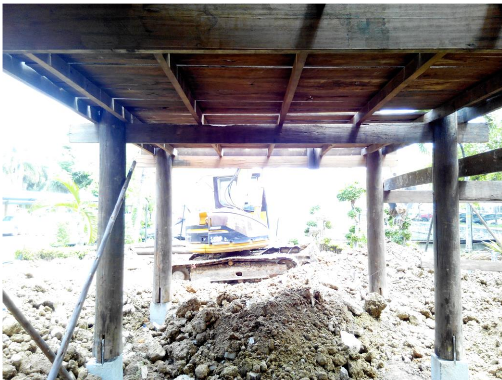
ภาพที่ 17 โครงสร้างส่วนใต้ถุนประกอบด้วย เสา รอด พรี้ง ตง และไม้กระดานพื้น
