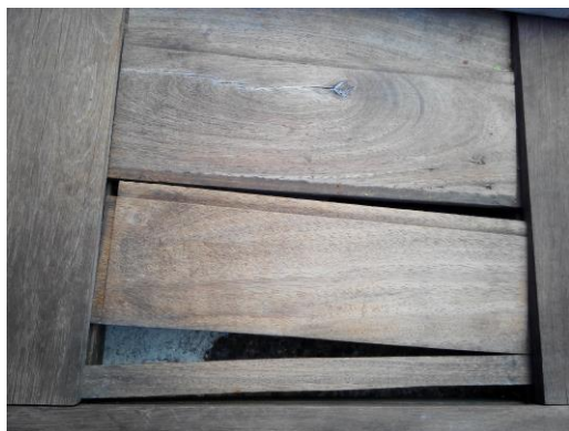
ภาพที่ 9 ไม้กรุฝาสอดเข้าร่องลูกตั้ง
