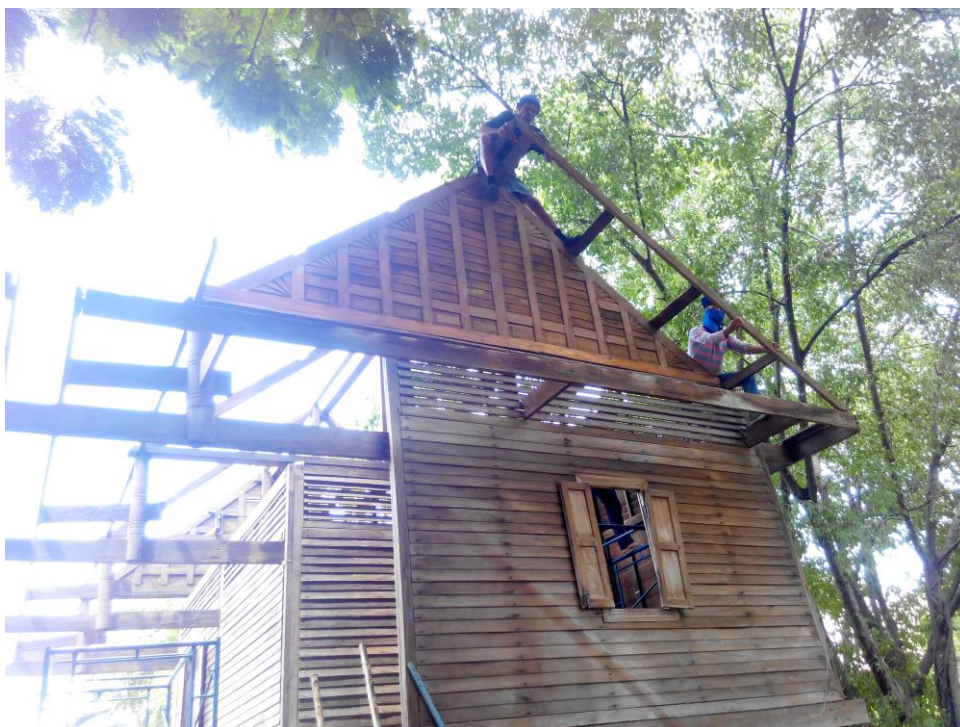
ภาพที่ 21 โครงหลังคาส่วนหน้าจั่ว เเชิงชาย และบันลม
