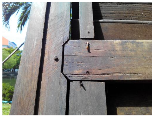
ภาพที่ 14 การเข้าไม้บริเวณรอยต่อระหว่าง กรอบฝา เกร้านั่งและเกร้านอน
