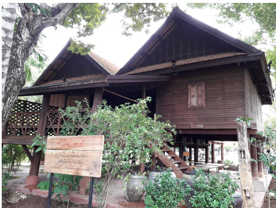
ภาพที่ 2 เรือนพ่อคงมีลักษณะเป็นเรือนแฝดที่มีเรือนนอนสองหลังวางขนานกันคั่นกลางด้วยโถงกว้าง
