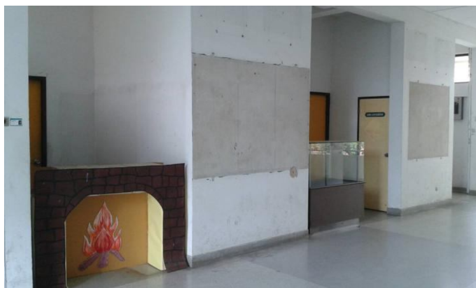
สถานที่ก่อสร้างห้องคลังโบราณวัตถุ
