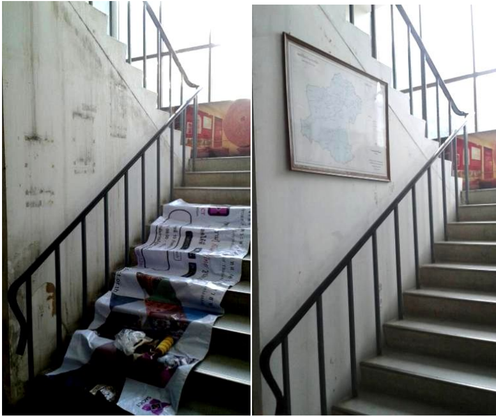
ทาสีขาวบริเวณทางขึ้นบันได ชั้น ๑
